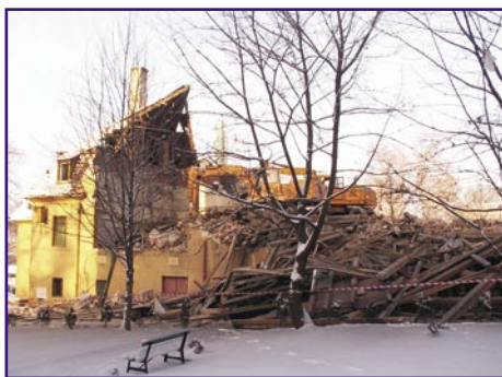
... i po rozbiórce
