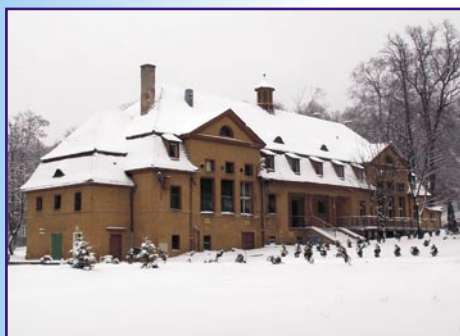
Budynek przed rozbiórką...
